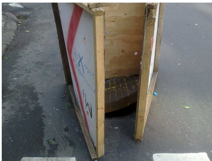
Figura 3: Isolamento e sinalização de bueiro onde foi detectada uma concentração elevada de gás
